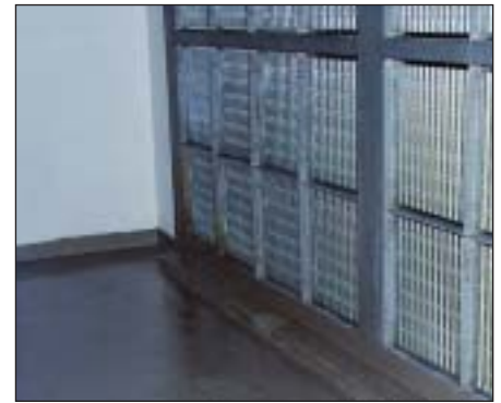
Der Zustand einer Anlage ist nicht unbedingt abhängig vom Alter. Eine gute Wartung verhindert aufwändige Sanierungsmassnahmen.
